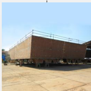
Costruzione e fornitura paratoie di Lido sud
