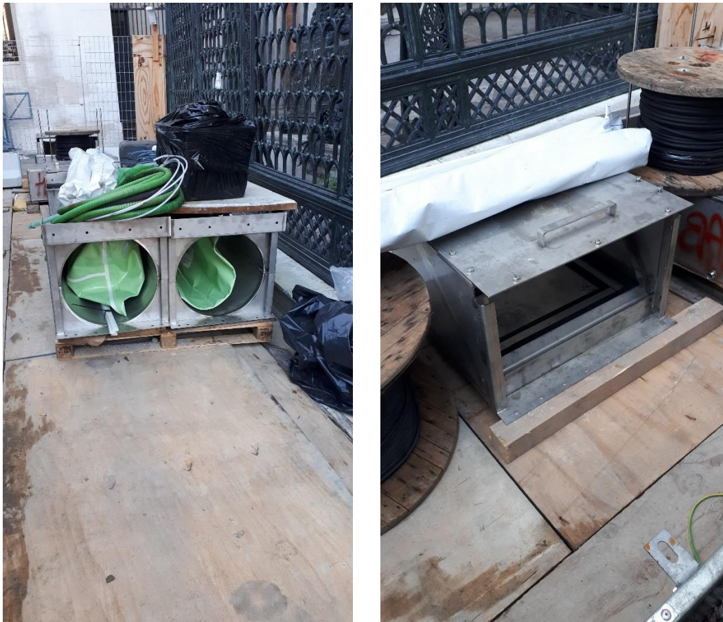
Figura 7 valvole a cilindro e a ventola pronte per l'installazione nei pozzetti in calcestruzzo realizzati in opera
