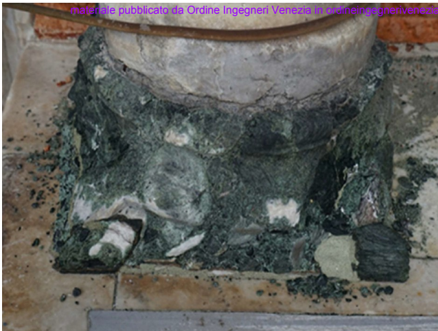
Disgregazione di una colonna di verde antico
