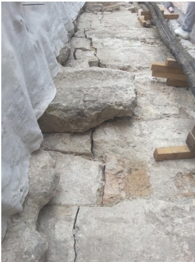
Fratture delle mensole della balaustra
