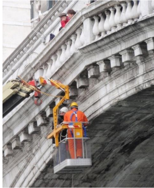
Alcune fasi di installazione delle mire
