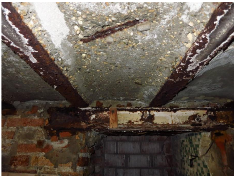
Solai inseriti in epoca recente in pessimo stato di conservazione
